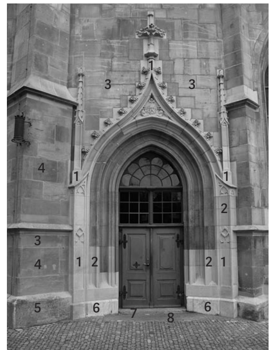
▲ Kindbetterinnen-Türe am Münster aus verschiedenen Gesteinen: Nr. 1 Obernkirchener Sandstein, Nr. 2 Zuger Sandstein, Nr. 3 und 4 Berner Sandstein, Nr. 4 wahrscheinlich vom Gurten, Nr. 5 Muschel nagelfluh, Nr. 6 Berner Oberländer Kalkstein, Nr. 7 Türschwelle aus Aare-Granit, Nr. 8 Kieselkalkschiefer auf dem Vorplätzchen. Foto: Labhart/Zehnder, Zahlen vergrössert
