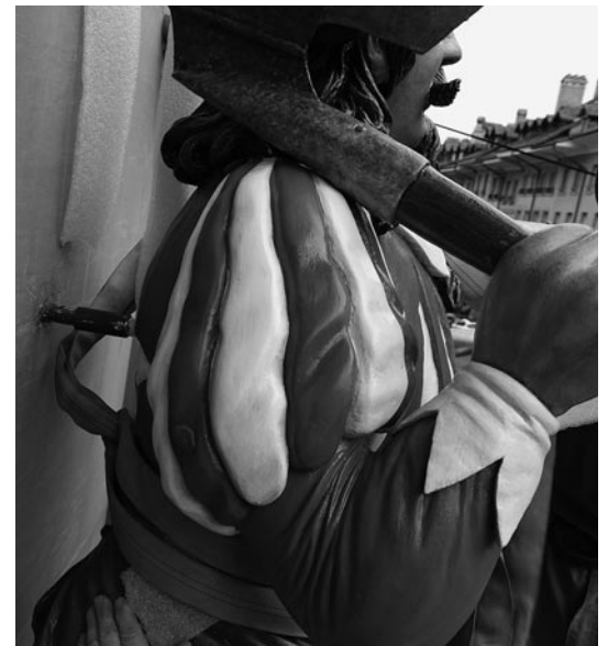
▲ Noch wird er an der Hüfte gehalten, noch sichern die Krangurten, doch der Zimmermann hat seine neue Verankerung an der Fassade, hat wieder seinen Platz.
