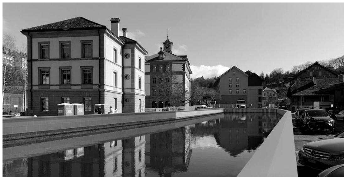
▲ Um den Tych werden die Mauern abgedichtet und erhöht. Zudem wird der Steg angehoben, um einen durchgehenden Hochwasserschutz zu gewährleisten. Visualisierung: TVS
