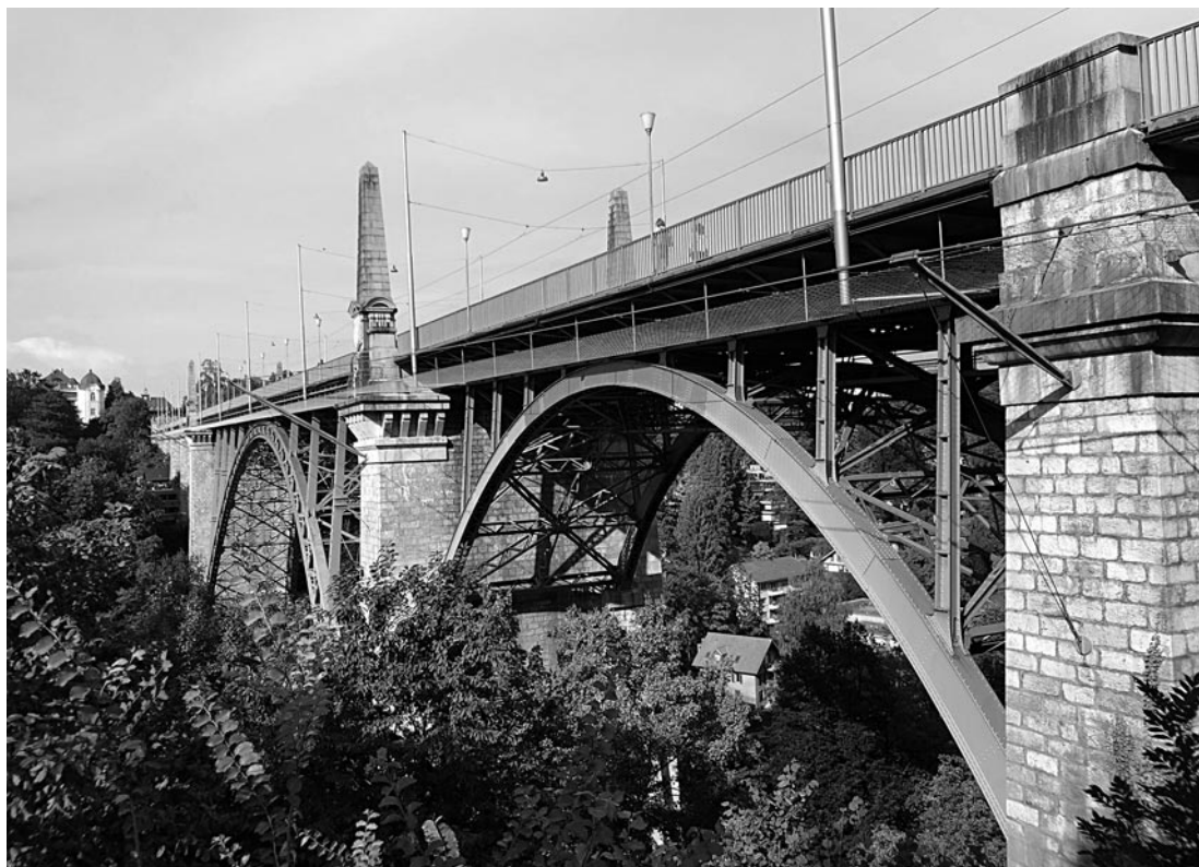
▲ Die Kornhausbrücke mit Blick nach Norden in Richtung Kursaal. Der Bogen im Vordergrund ist einer von insgesamt fünf kleineren Brückenbögen. Im Bild hinten links ist der grosse Bogen mit einer Spannweite von 115 Metern zu erkennen.
