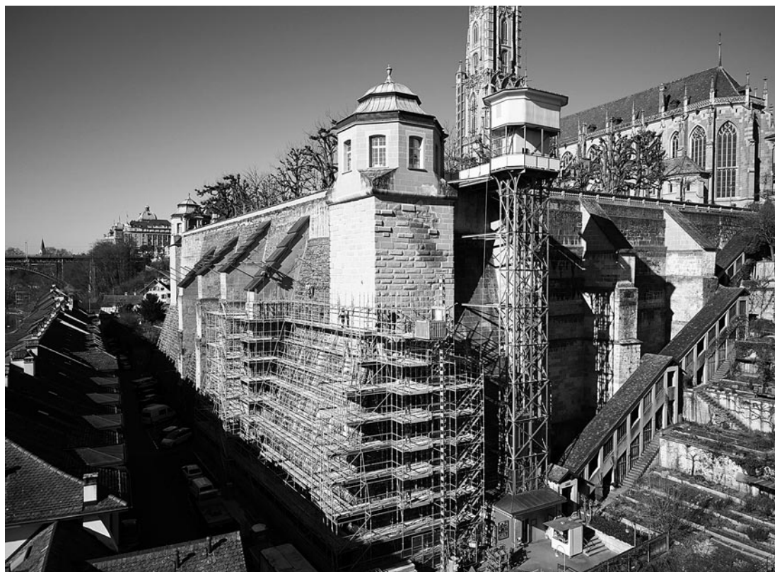
▲ Eindrücklicher Gerüstaufbau an der Pläfewand. Foto: HSB
