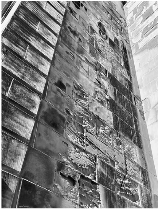
▲ Wie von einem Bildhauer gemeisselt wirken diese Abwitterungen. Rechts oben sind üppige Salzausblühungen zu erkennen.
