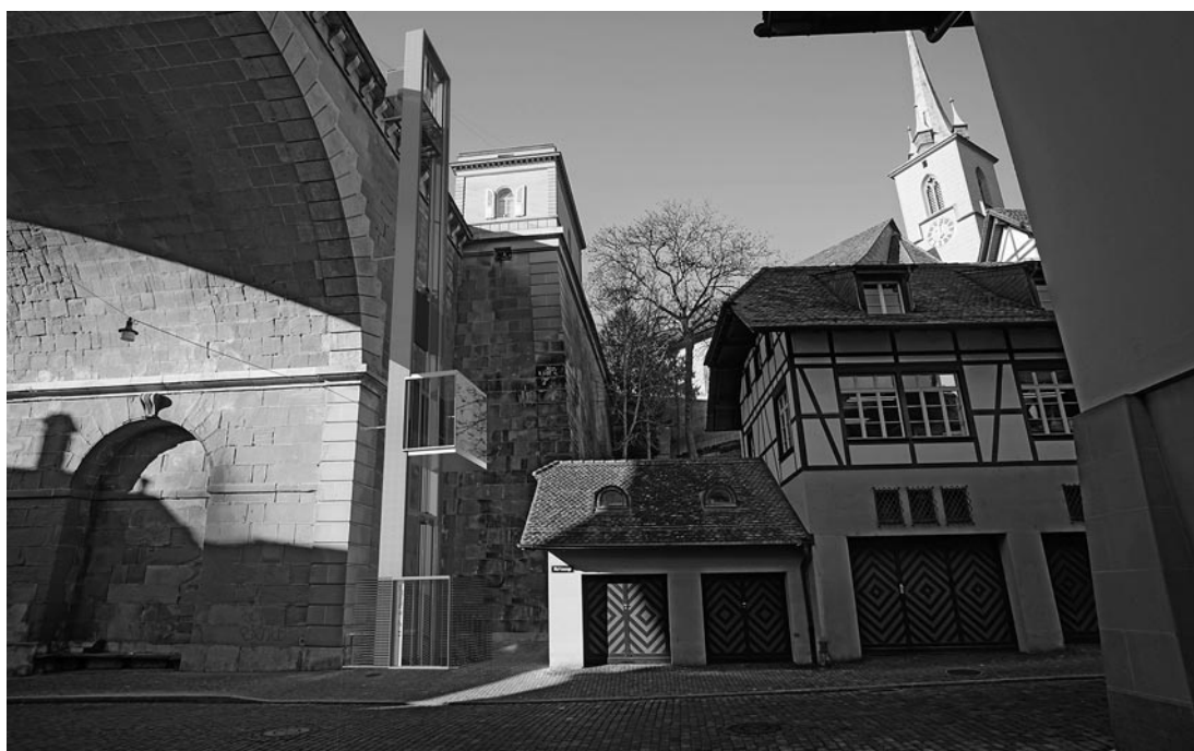
▲ Der untere Eingang befindet sich in der Matteneuge. Die Liftkabine aus Glas und Chromstahl ist 1,40 x 2,30 m gross und fasst ca. 20 Personen. © Walter Hunziker
