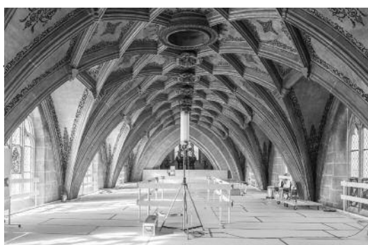
▲ Die Restaurierung des Mitteschiffgewölbes hat begonnen.
