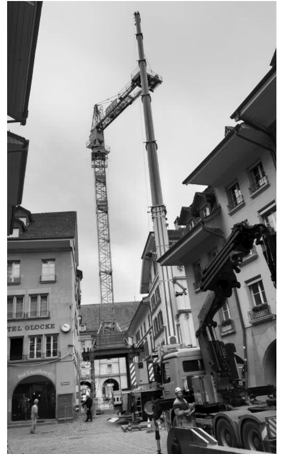
▲ Radkran und Baukran am Flirten.
