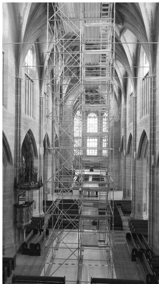
▲ Das riesige, ganze zweiundzwanzig Meter hohe Sondiergerüst im Münster-Mittelschiff.
