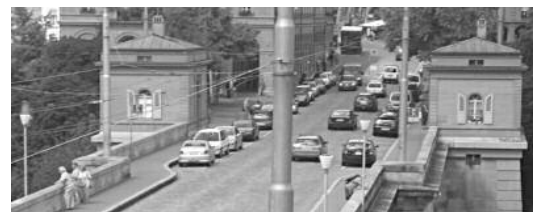
▲ Die beiden 1843 erbauten stadtseitigen Zollhäuschen. Im Vordergrund ist das Geländerprofil nach Moscas Vorbild deutlich zu sehen. (Foto: Stephan Probst)
