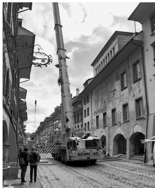
▲ Imposante Kranmontage in der Rathausgasse.
