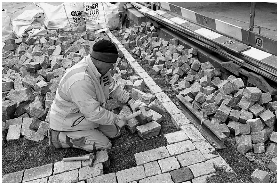
▲ Jeder einzelne Stein wird von Hand zurechtgehauen.
