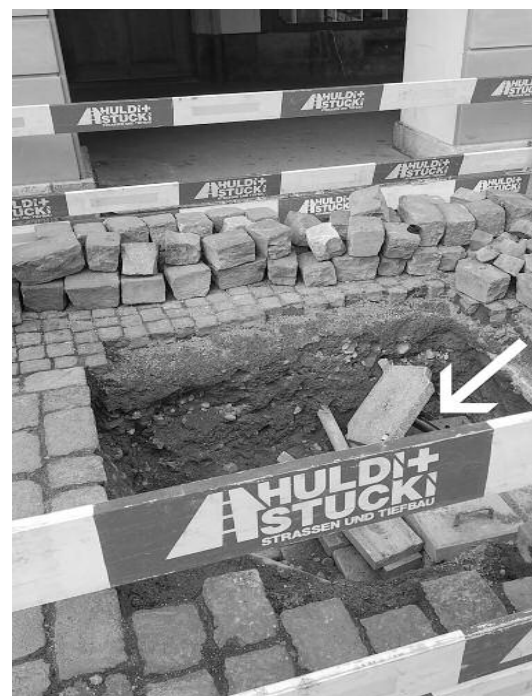
▲ Glasfasereinführung (Pfeil) am «offene Bsetzstei-Härz» in der Münsterergasse.
