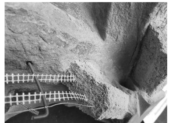
▲ An diesem defekten Schaustück ist bereits die metallene, leiterförmige Armierung fixiert worden, um später daran den Mörtelaufbau zu verfestigen.
