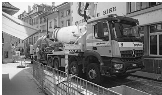
▲ Beginn der Arbeiten am 17. Juli, das Kranfundament wird betoniert...
