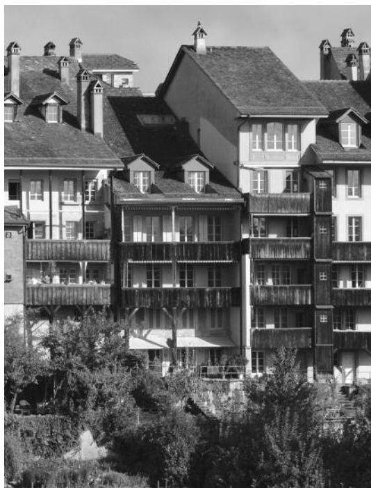
▲ Vollständig in (trockenem) Holz gearbeitete Aareseitige Balkone der Herrengass-Häuserzeile sprechen für Nulltoleranz gegenüber Feuerwerk (!)
