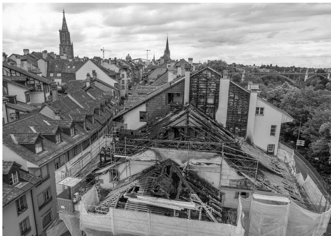
▲ Vordergrund: der völlig ausgebrannte Dachstock an der unteren Postgasse. Hintergrund: das unmittelbar angebaute Nachbarhaus konnte von der Feuerwehr geschützt und gehalten werden. Foto: zVg
