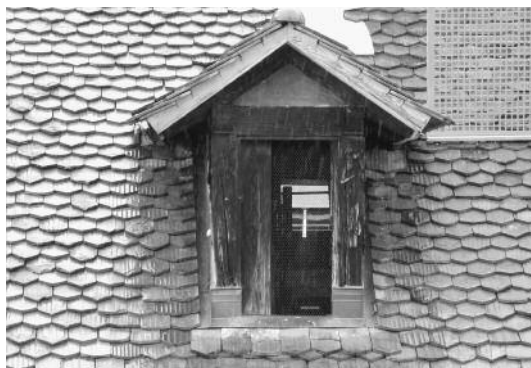
▲ Ausgesetzte (offene) Holzlukarne zwischen Kram- und Münstergasse. Lediglich ein grobmaschiges Drahtgeflecht hält die Tauben ab; nicht aber unkontrolliert fliegende Feuerwerkskörper...
