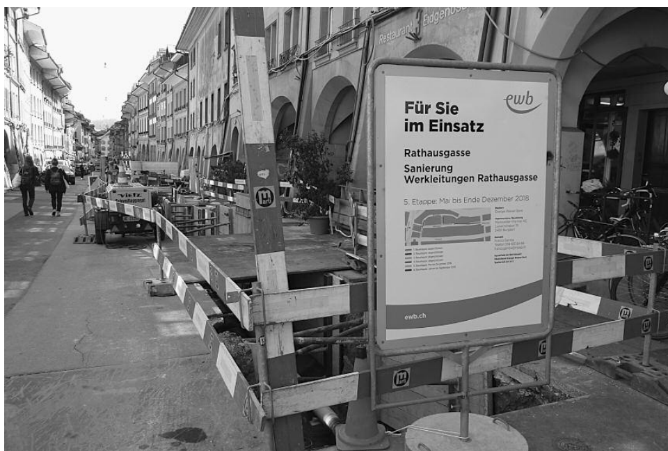
▲ Baustelle Rathausgasse Etappe 5: Obere Hälfte bis Ende 2018.
