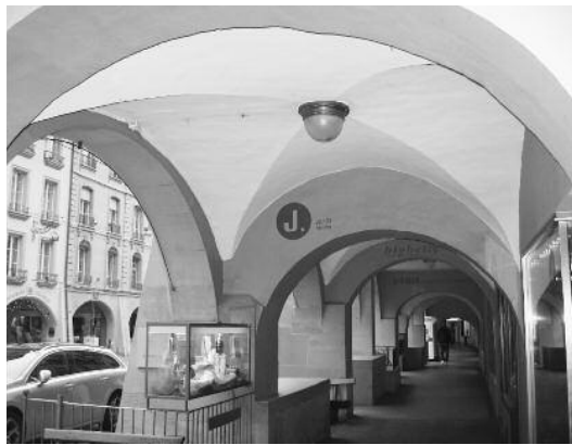
▲ Laube mit Kreuzgewölbe von 1485/6 an der Gerechtigkeitsgasse 71/73
