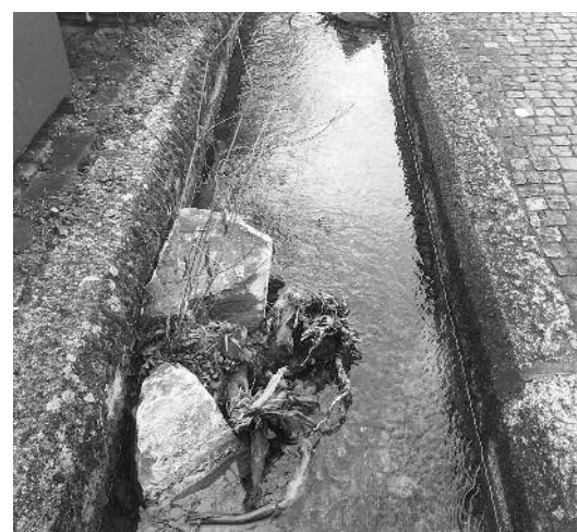
▲ Im Zuge der Naturierung wurden Blocksteine und Wurzelstöcke eingesetzt.
