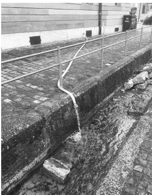
▲ ...führt das nach oben drückende Grundwasser zurück in den Mattebach.
