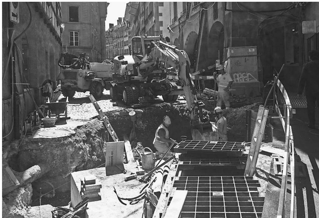
▲ Kleine Gasse – Grosse Baustelle.
