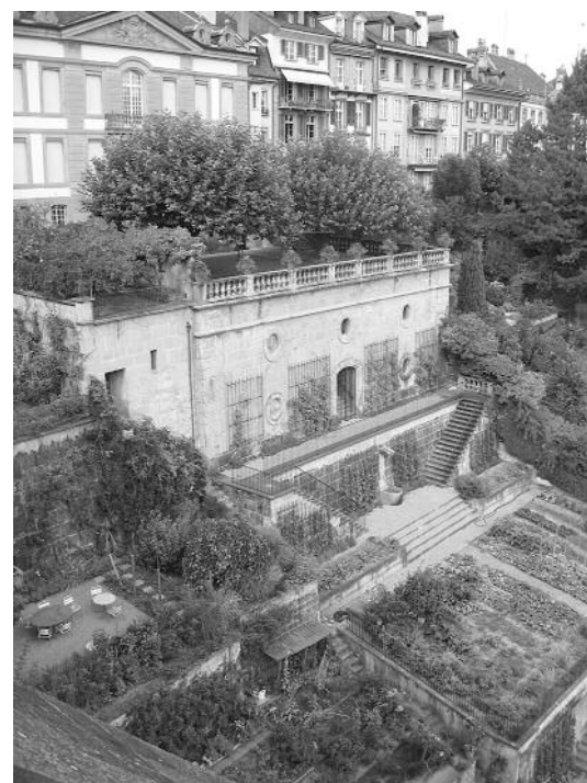
▲ Die Südfassade des Beatrice von-Wattenwyl-Hauses mit seinen «hängenden Gärten von Bern». Oben die vornehme Rasenterrasse mit den zwei grossen Platanen und der Steinbalustrade.
