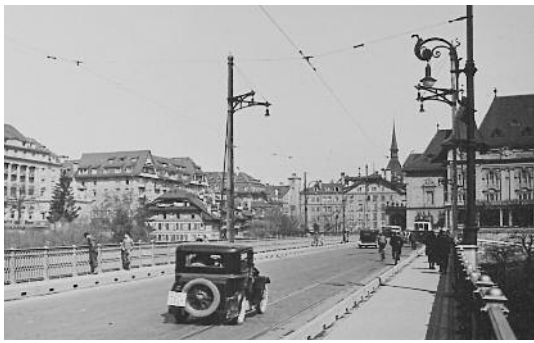
▲ Der Verkehr nimmt ständig zu: 1933 führten zwei Geleise über die Brücke, der Automobilverkehr hatte die Pferdefuhrwerke endgültig abgelöst. Die ursprünglich eiserne Fahrbahn war bereits 1913/14 mit einer Stahlbetonplatte mit aufgelegtem Holzbelag verstärkt worden. Im Hintergrund jetzt der markante Bau des Casinos. (Burgerbibliothek Bern, FPa.3, S. 2, Nr. 1)
