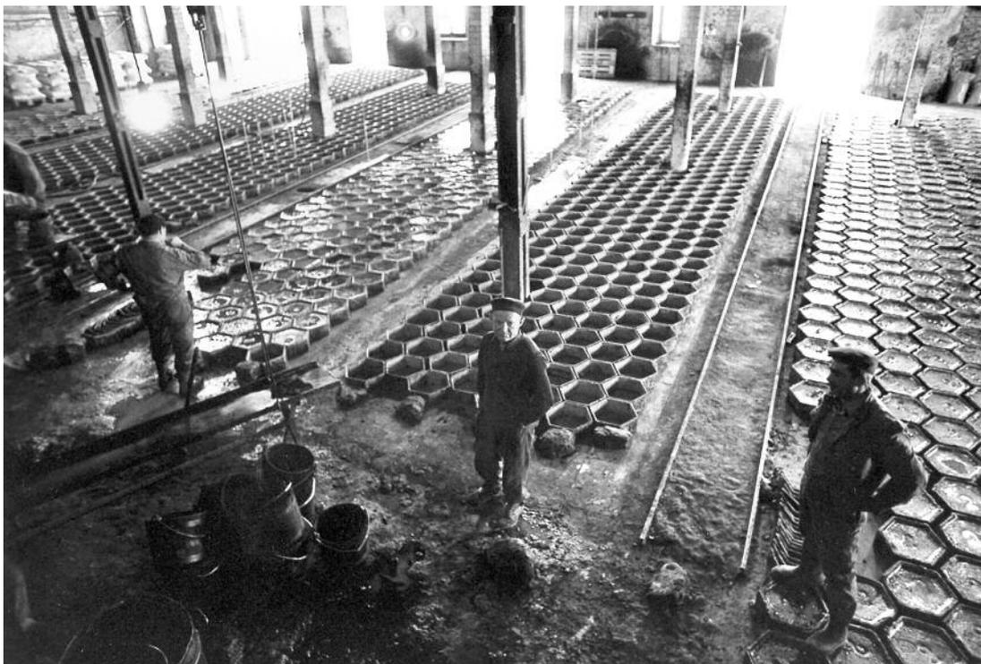
▲ Die Herstellung der Asphaltbrote nach dem Mahlen und nach dem Umschmelzen (© Goût&Région 2012)
