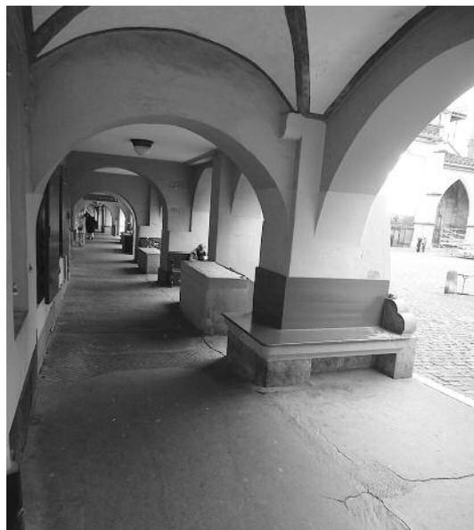
▲ Belag in der Laube der Münstergasse 32, teilweise Gussasphalt, teilweise behauene Steinplatten. In der Gasse: Pflastersteine.
