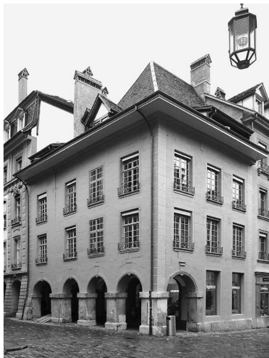
▲ Junkerngasse 58: Die Fassade zur Kreuzgasse lässt erkennen, dass der linke Teil ergänzt wurde. Das Eckhaus stand ursprünglich frei, in der Lücke zum kramgasseseitigen Haus befand sich eine offene Treppe. ef
