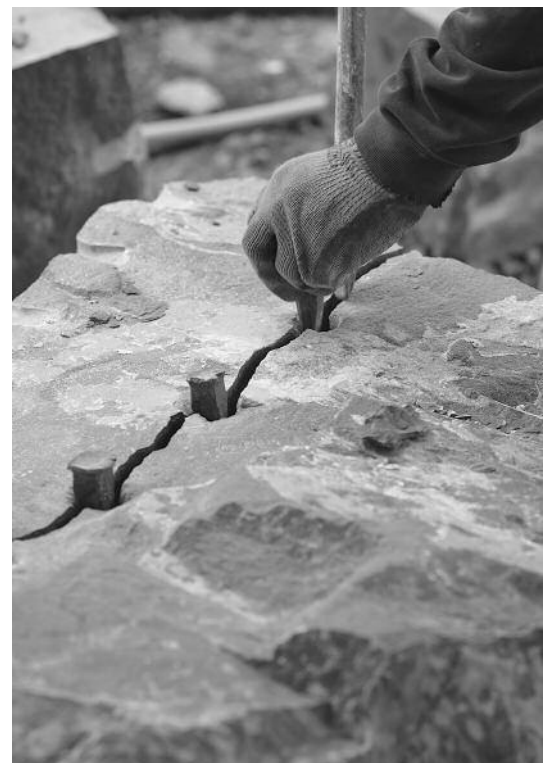
▲ Guber: Spalteisen in Reihenbohrung bei der Blockzerkleinerung.
