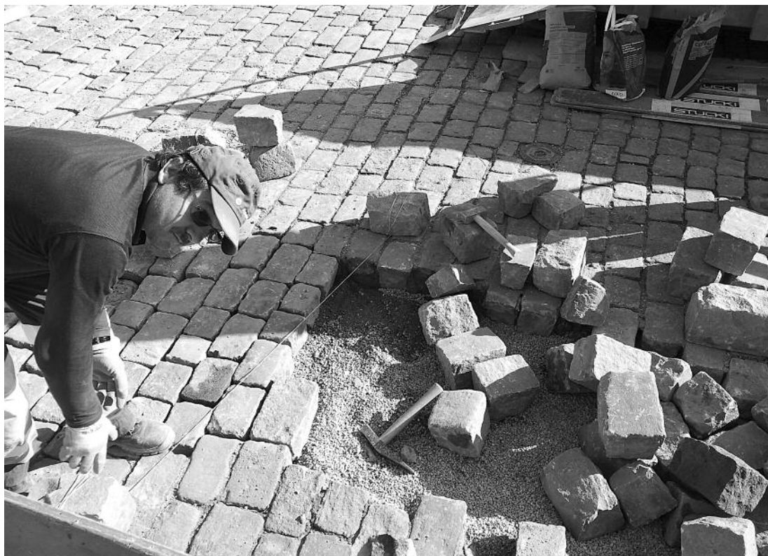
▲ Verlegen von Binder(Bsetzi-)steinen auf dem Münsterplatz; mit eingesandeten Fugen.
