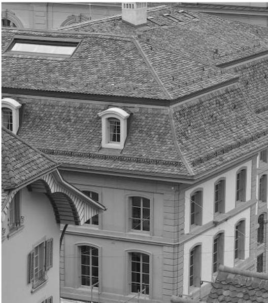
▲ Detail (oben) neue Dachflächen-Fenster mit darunterliegendem Grossraumbüro (Blick vom Zeitglockenturm). sw
