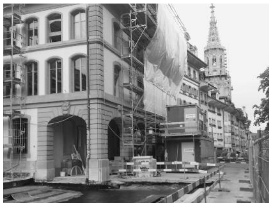
▲ Umbau Archiv- und Bibliotheksgebäude beim «Entpacken» (Seite Herrergasse)
