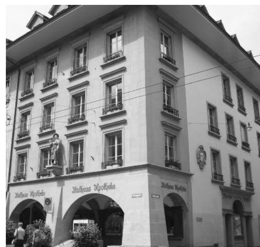
▲ Kramgasse 2 – Frühbarocke Fassade um 1710, Hans Jakob Dünz III. zugeschrieben; durch hohe Fenster und starke Simse klar rechteckig strukturierte Fassade. Das Palladio-Portal an der Ostfassade (um 1824) ist bereits klassizistisch. Seit 1953 Sitz der Zunft zu Zimmerleuten. Ähnlichkeit mit Münster-gasse 32.
